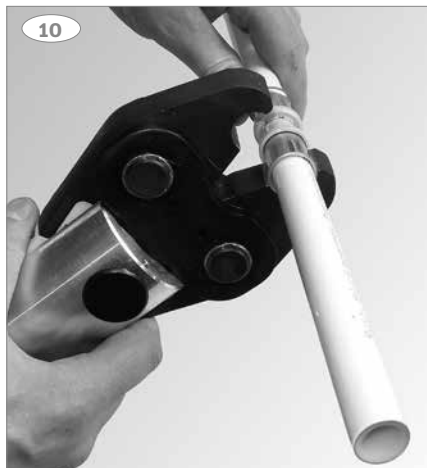
10: Placer presbakken (til 16 - 32 mm) på presringen mellem plastdelen og presringens vulst.
