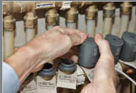
VVS-installatøren skifter termomotorerne.
