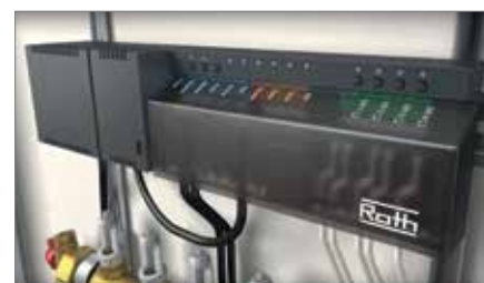
1. Monter kontrolenheden og tilslut termomotorerne.
